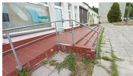
FOT. 15. WIDOCZNE USZKODZENIA NAWIERZCHNI, SCHODÓW I POCHYLNI
