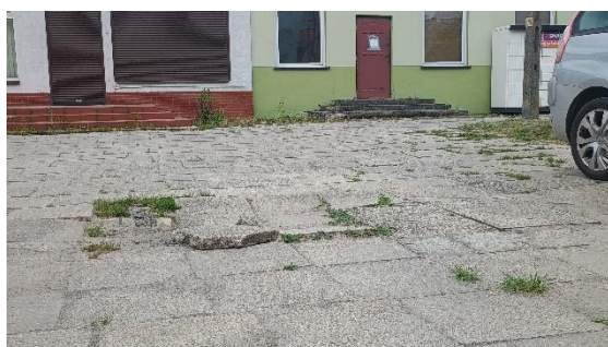
FOT. 14. WIDOCZNE USZKODZENIA NAWIERZCHNI
